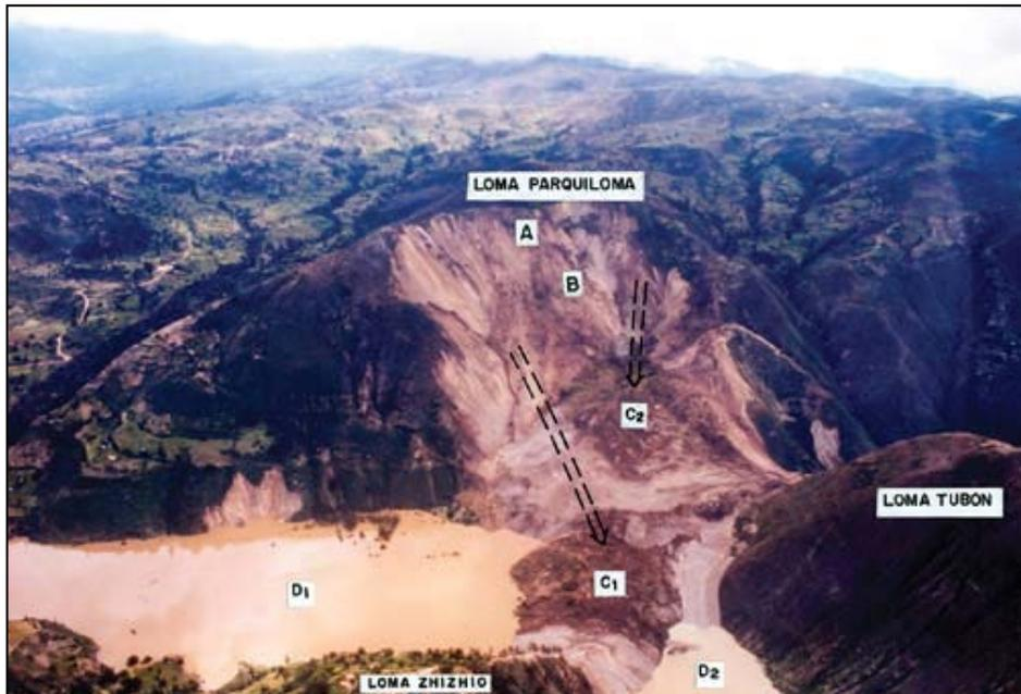
**Figura N° 19:** El deslizamiento-represamiento de La Josefina (05-04-93): A, escarpe. C1, dirección y depósito del primer movimiento. C2, dirección y depósito del segundo movimiento.
